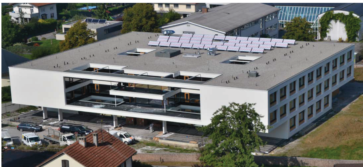
Die Abschlussarbeiten im Pflegeheim Höchst-Fußach sind voll im Gang, das Gebäude fügt sich ansprechend in seine Umgebung ein.
